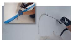
Die Heizfolienanschlüsse sowie die Zwillingsanschlusskabel in den Untergrund einlassen/ schlitzen oder in die ggf. verwendete Dämmplatte einlassen. Anschließend werden die Schlitze verschlossen und die Flächen grundiert.
