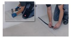
Bei elektrischen Fußbodenheizungen ist nach EN 50559:2013-12 ein Bodenfühler vorgeschrieben. Die Fühlerhülse (Aluminiumblock) 60 cm von der Wand entfernt in den Raum hinein mittig unter einer Heizfolie mit dem Wellrohr anzeichnen und einlassen.
